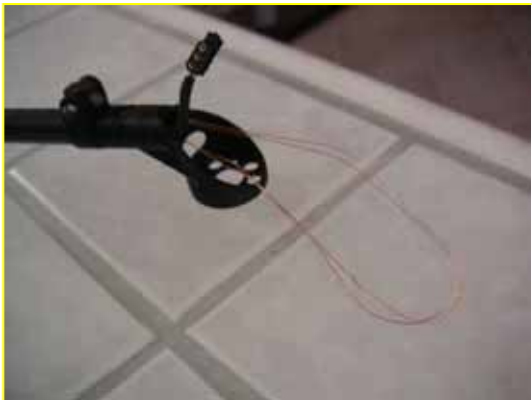
Les fils rentrent doucement dans la poutre.
